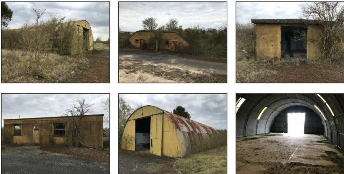
Figure 5 - Bâtiments dans le DAMS (source : PHOTOSOL)
