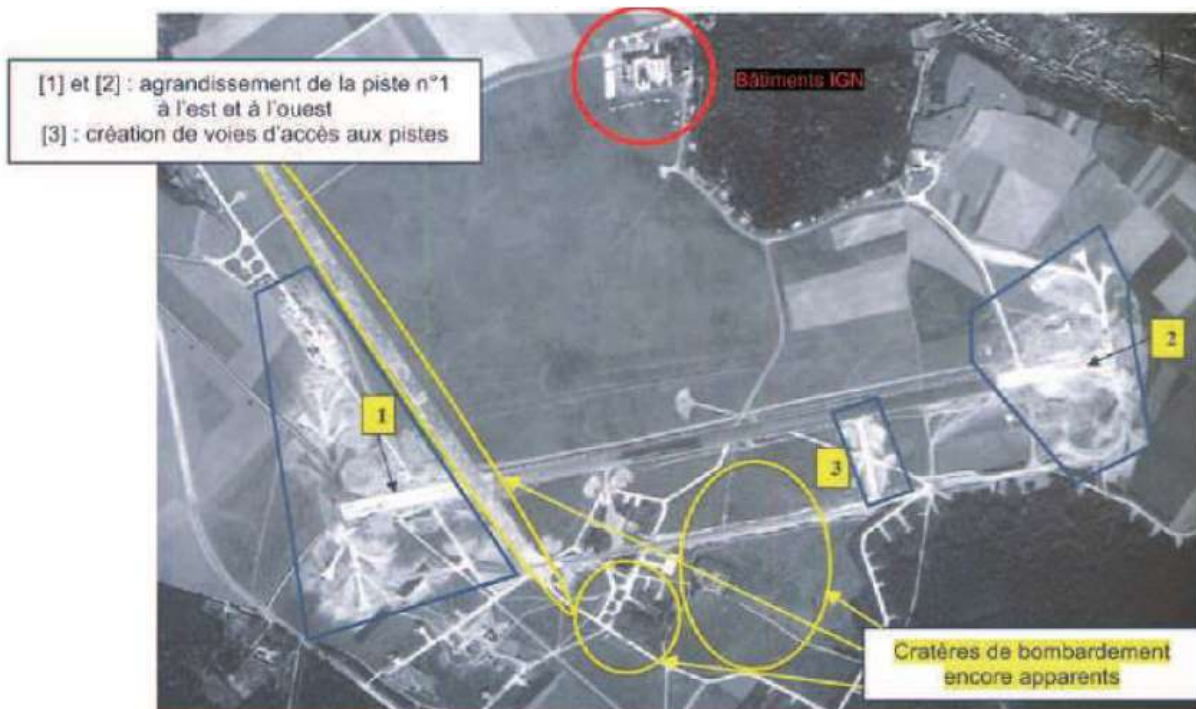
Figure 2 - Vue aérienne de l'aérodrome de Creil en 1951 (source : SGa, Étude historique et technique de pollution pyrotechnique, BA 110 – Creil)
