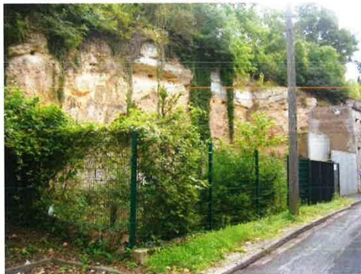
Protection des fronts de roche
