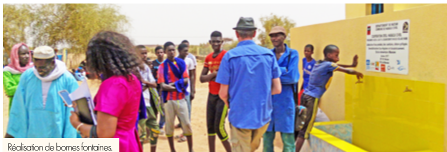
Réalisation de bornes fontaines.
