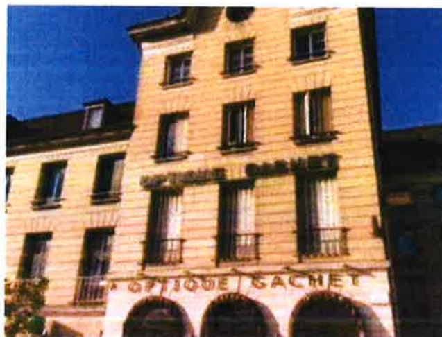
Redondance du message véhiculé par les enseignes parallèles au mur, mars 2021, Creil.
