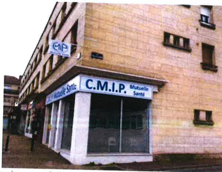
Exemple d'enseigne perpendiculaire non alignée avec l'enseigne parallèle au mur, mars 2021, Creil.
