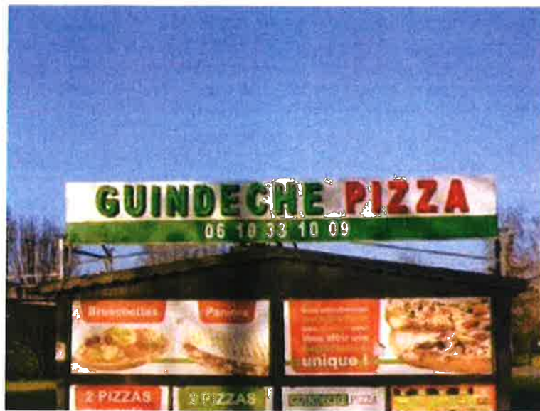
Enseigne sur toiture ou terrasse en tenant lieu, non réalisée avec des lettres découpées, mars 2021, Creil.
