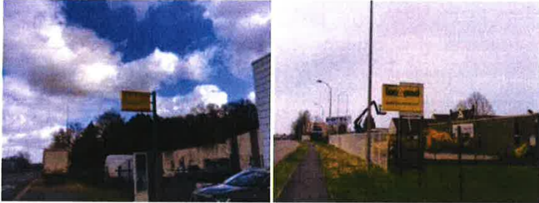
Enseignes scellées au sol ou installées directement sur le sol ne respectant pas la règle dite « H/2 », qui impose une implantation de ces enseignes à au moins la moitié de leur hauteur d'une limite séparative de propriété, mars 2021, Creil.
