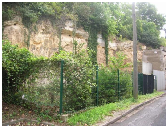
Protection des fronts de roche
