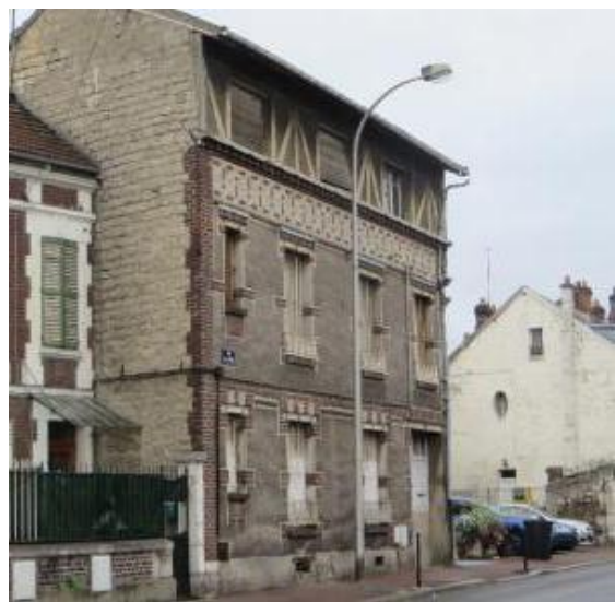
Façade Avant sur rue
