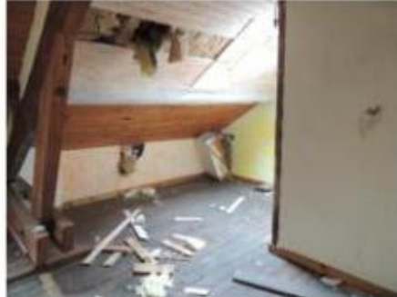
Etat intérieur de l'immeuble
