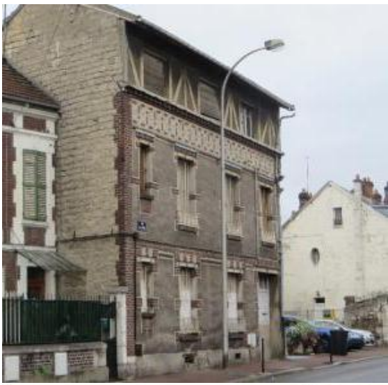
Façade Avant sur rue
