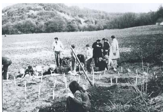
Dimanche 24 mars 1974 : début des travaux sur le site de l'écluse
