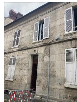
Photo 20 - appuis fissurés
