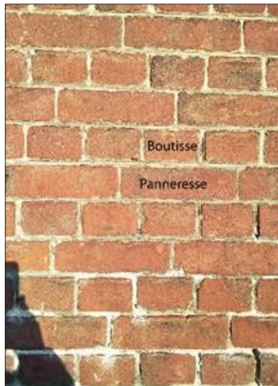
Photo 3 - 5 quai d'aval (Creil) Zoom sur le système d'appareillage : panneresse / boutisse
