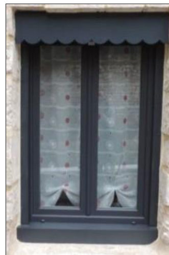
Photo 17 Coffre de volet roulant positionné vers l'extérieur / Coffre dissimulé
