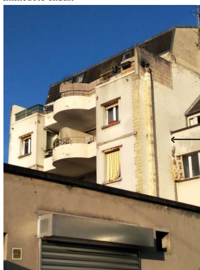
Photo 6 - 2 quai d'aval (Creil)
