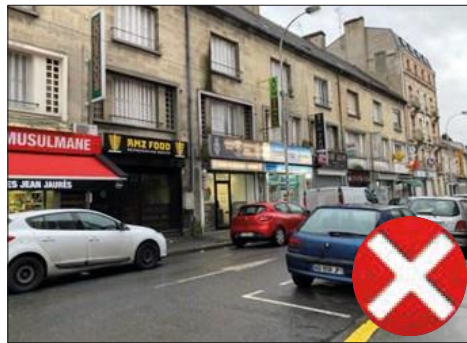
Photo 22 - Commerces sur la rue Jean Jaurès. Caissons des rideaux en saillie, enseignes-drapeau positionnées aux étages de la façade.
