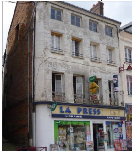
Photo 12 Badigeon sur maçonnerie en pierre. Bolbec (76)
