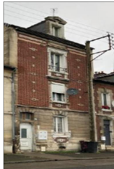
Photo 1 - 6 quai d'Aval (CREIL)
