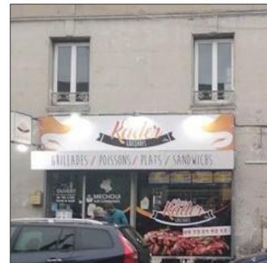
Photo 8 - 38-40 rue Jean Jaurès : Zoom sur l'enduit.
