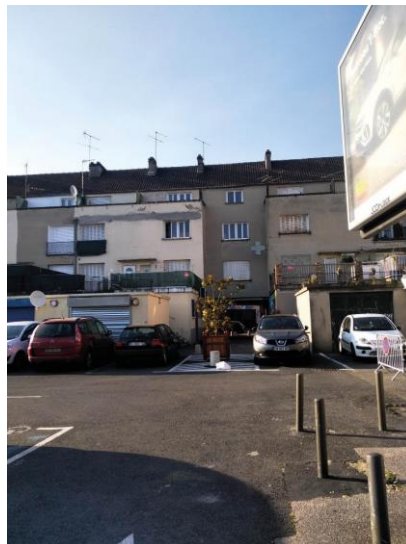
Photo 5 - 1 quai d'aval (Creil) : Immeuble enduit
