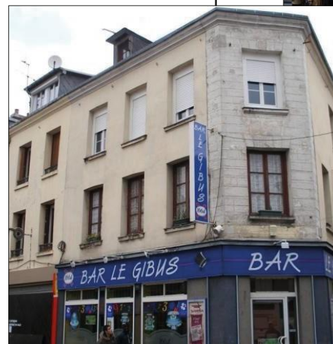
Photo 24 - Enseigne drapeau à l'étage, supprimée.
