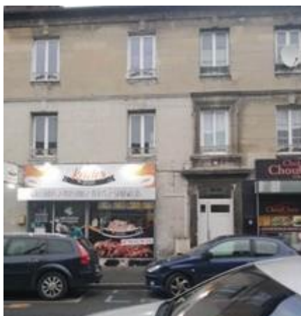
Photo 7 - 38-40 rue Jean Jaurès (Creil) Immeuble en pierre de taille partiellement enduit
