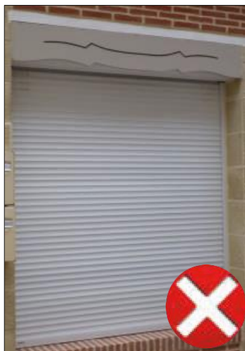
Photo 17 Coffre de volet roulant positionné vers l'extérieur / Coffre dissimulé
