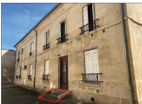
Photo 21 - Marches d'accès non protégées transmettant l'humidité vers l'intérieur.
