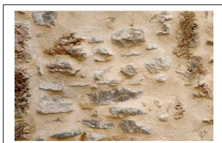
Photo 11 - Mur enduit à pierre vue
