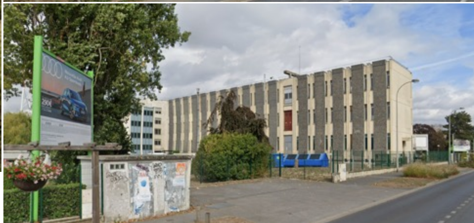
Entrée de ville Boulevard S. Allende – Forte densité de supports sur cet axe
