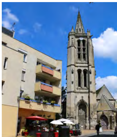
» Restauration de l'église Saint-Médard
