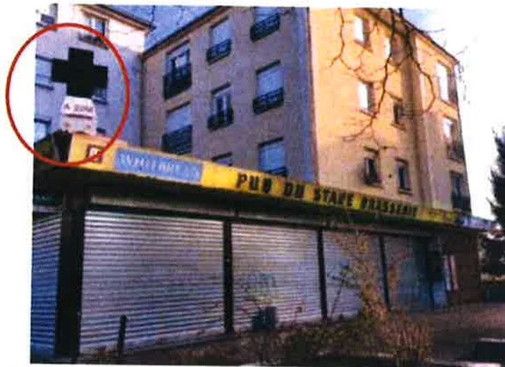
Publicité lumineuse sur toiture ou terrasse en tenant lieu, mars 2021, Creil.
