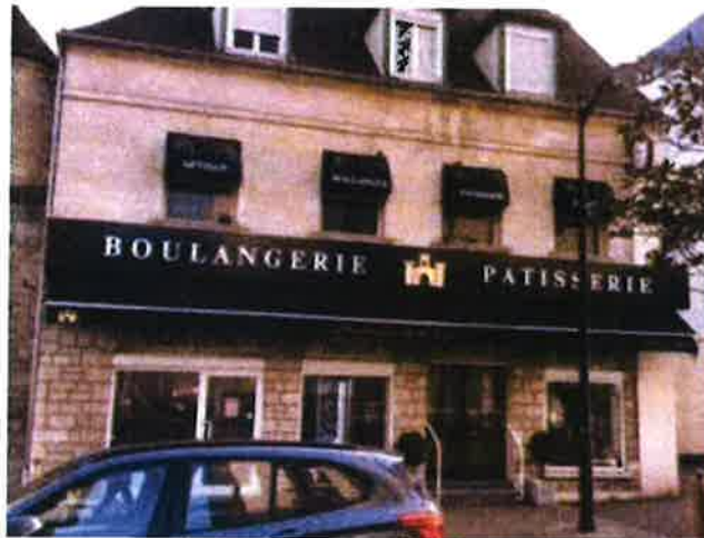
Enseigne parallèle au mur en bandeau masquant une partie du bâtiment. Redondance du message véhiculé par les enseignes parallèles au mur, mars 2021, Creil.
