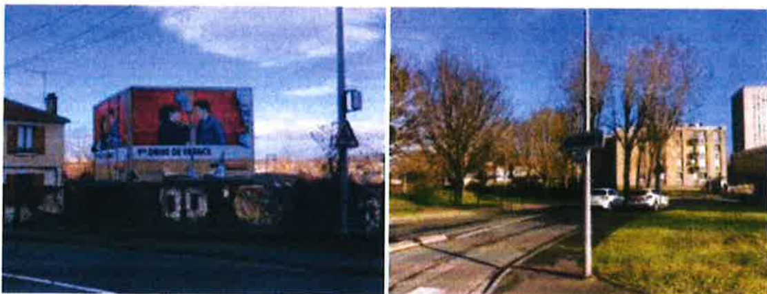
Publicités / préenseignes scellées au sol ou installées directement sur le sol avec passerelles fixes et en mauvais état d'entretien et publicité / préenseigne installée sur un poteau d'éclairage public, mars 2021, Creil.
