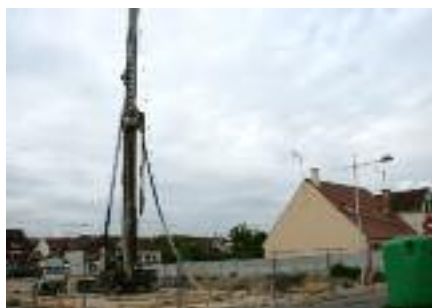
avant les travaux
