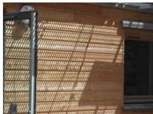
L'aspect des matériaux a été conservé : parpaings, parquet en pin, panneaux en fibre de bois, dalle béton, acier galvanisé, mélèze brut. Cela a permis d'obtenir un coût de travaux particulièrement compétitif et un style esthétique adapté au lieu.
