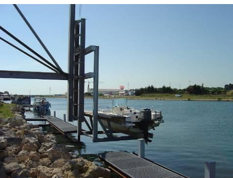
Grue de mise à l'eau
