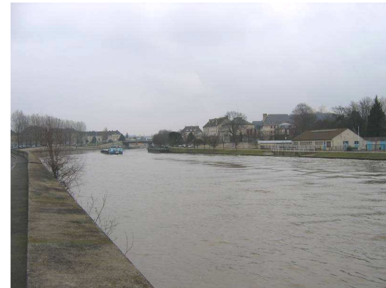
L'Oise vue du quai d'aval, au droit de l'Île-Saint-Maurice
