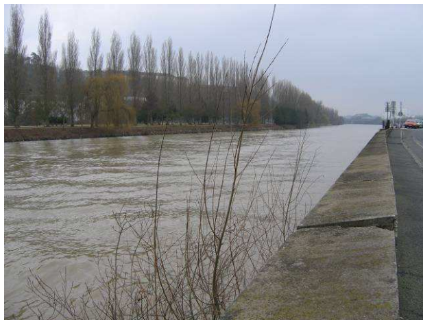
L'Oise au droit du quai d'aval, à hauteur de l'île Saint-Maurice
