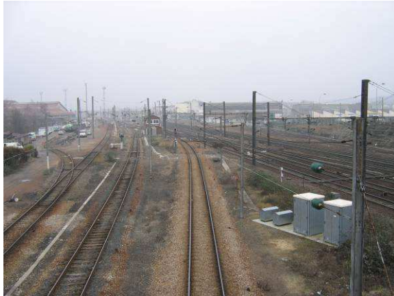
L'emprise ferroviaire vue du pont en Y
