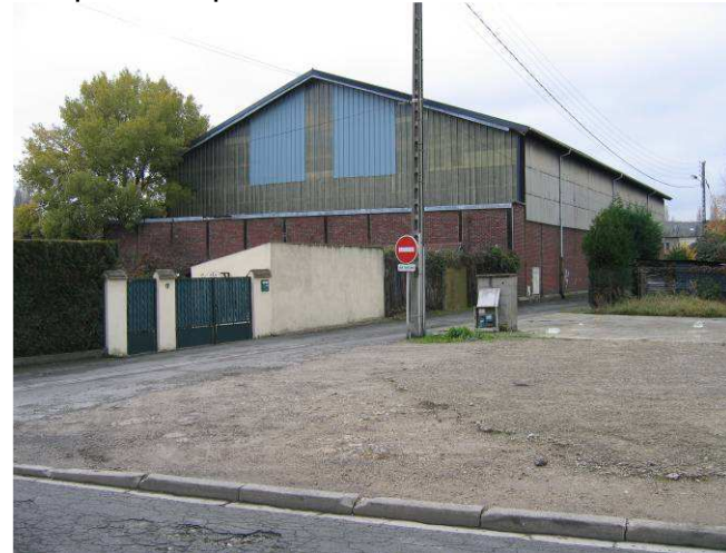
Espaces délaissés Rue Faure Robert
