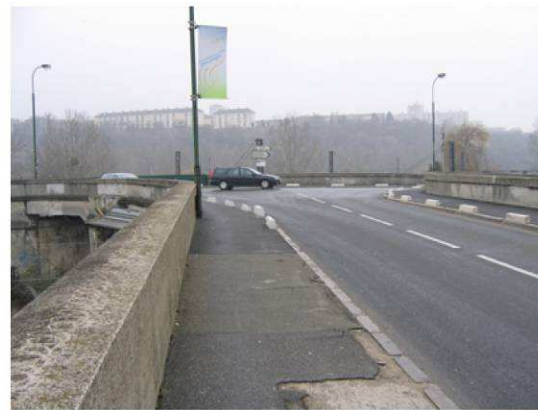
Pont Y surplombant les voies ferrées
