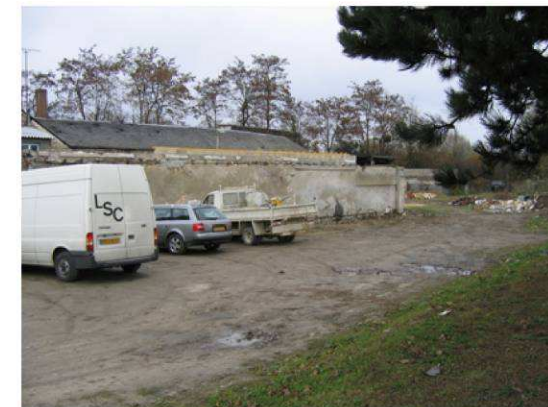
Arrière cour au droit du Carrefour des Forges
