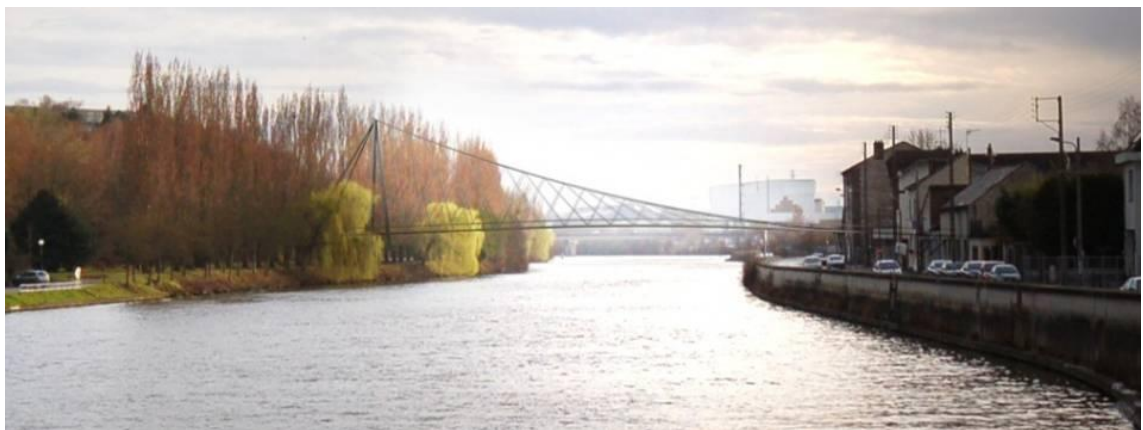
Vue de la passerelle
