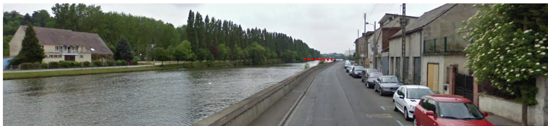
Vue du site depuis le Quai d'Aval
