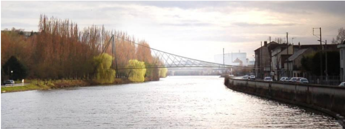
Vue de la passerelle
