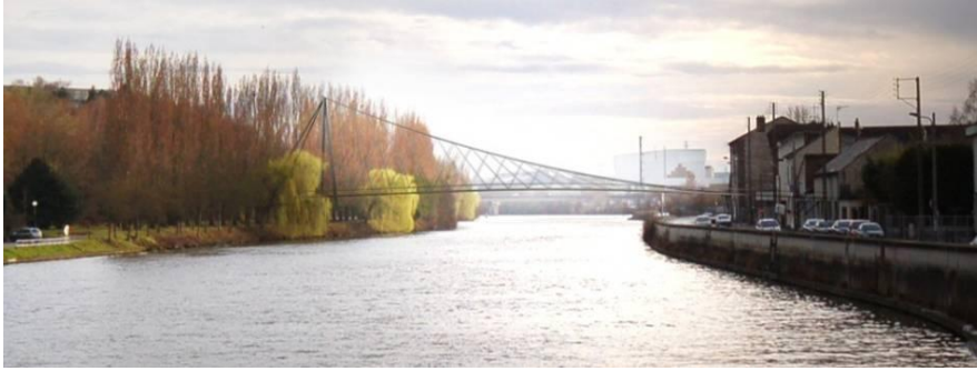
Vue de la passerelle
