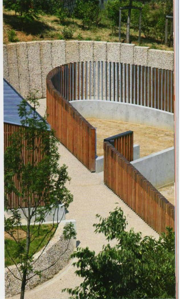
Une clôture en mélèze suit la « ficelle », filtre le regard, et habille les murs du périphérique, le haut des madriers étant protégés de l'infiltration des eaux par une couverture métallique.
