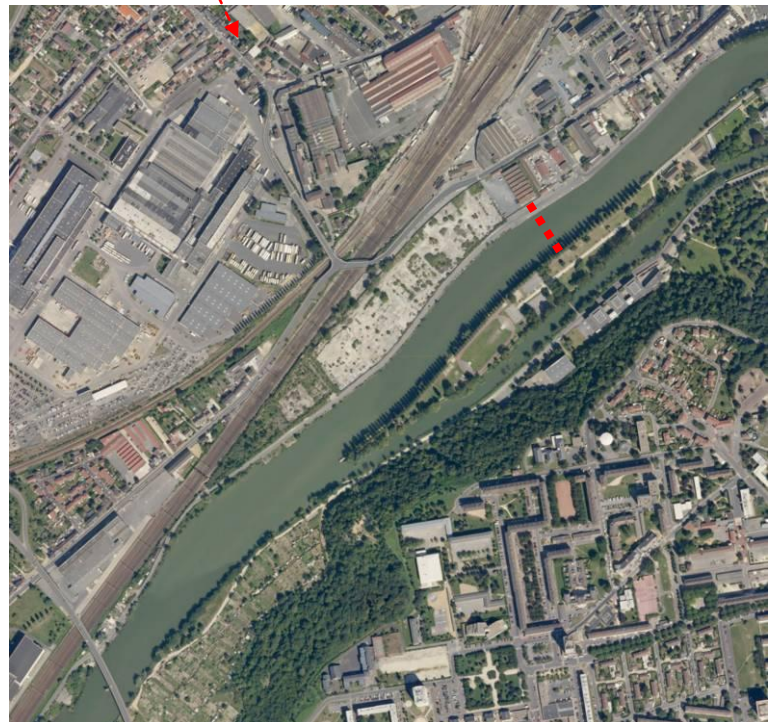
Photo de l'existant avec position du futur ouvrage
