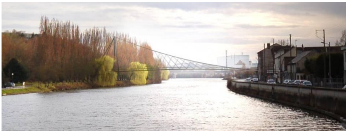
Vue de la passerelle
