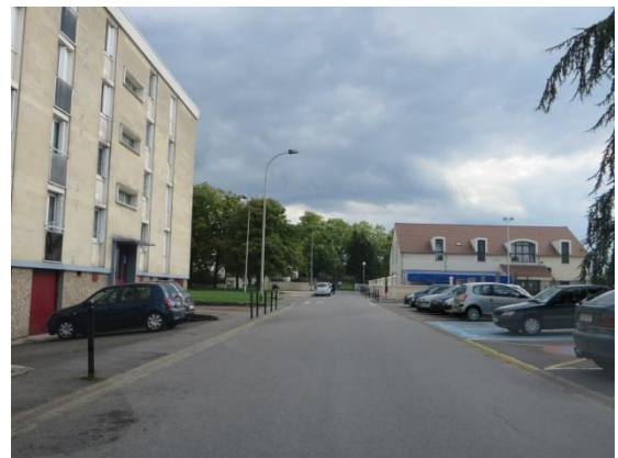
Rue Guynemer : vue sur le centre culturel, et en fond de perspective la parcelle du centre des impôts
