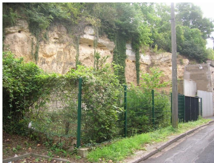
Protection des fronts de roche
