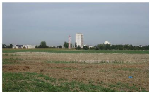
Vue du front urbain avec la tour Descartes et la cheminée de la chaufferie municipale
