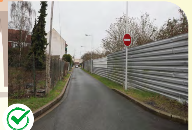
Rénovation de la voirie rue de la Chapelle des Marais, entre les rues Fauré Robert et la rue de Gournay, pour améliorer la circulation des piétons.
