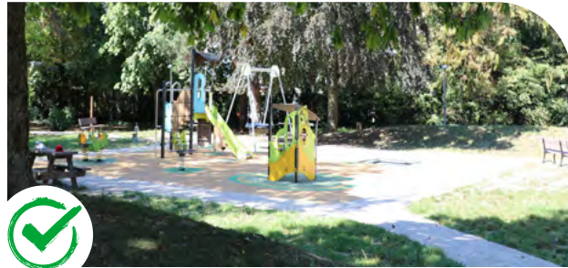
Le réaménagement du square Branly avec la réalisation d'une aire de jeux inclusive comprenant des équipements accessibles aux enfants de tous âges.
