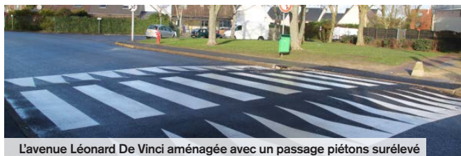
L'avenue Léonard De Vinci aménagée avec un passage piétons surélevé
